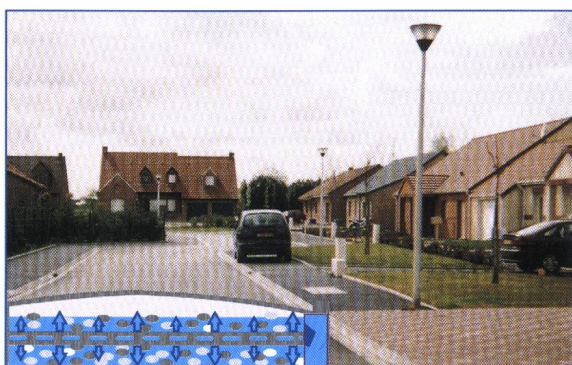
Revêtement imperméable : injection par un drain. (Cuincy, rue des Chardonnets)
